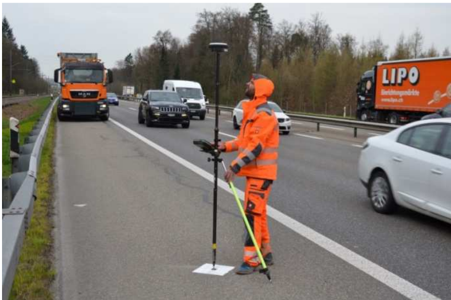
Abb. 3: GNSS-Messungen von Passpunkten mit LKW-Auffahrschutz.
