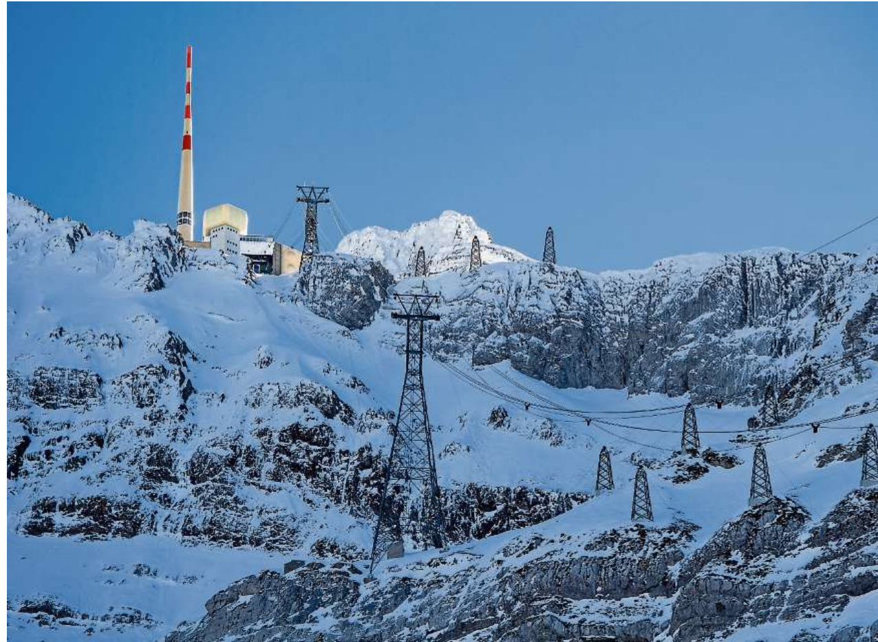
Steht seit über einem Monat still: Die Säntis-Schwebbahn, deren Stütze von einer Lawine getroffen und schwer beschädigt wurde.
